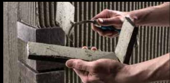
Die Eckwinkel werden im Floating-Buttering-Verfahren verarbeitet.
